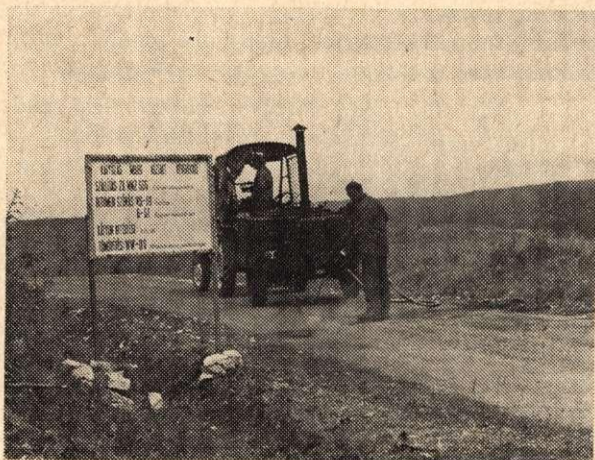
14. ábra. Hazai kátyúzós gépcsoport
