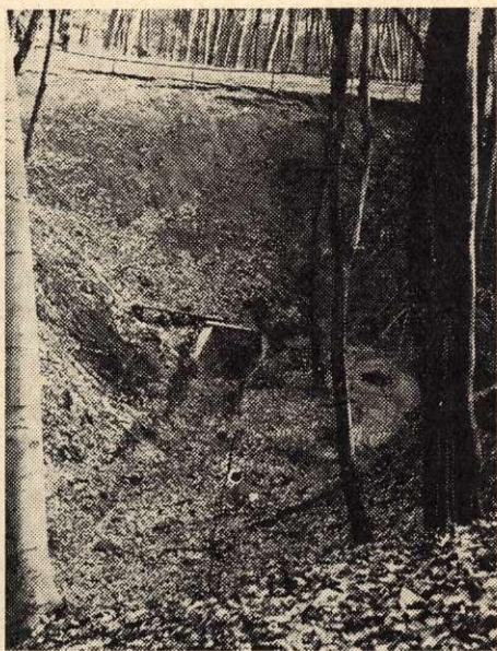
4. ábra. 118,5 cm névleges átmérőjű átereszt mély vízmosásban
