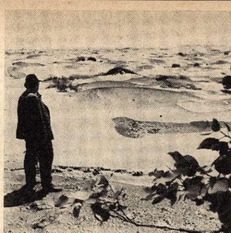
6. ábra. Ásványolaj-emulzióval bepermetezett homokdűnék ültetés előtt Khallet-al-Massaudi térségében
