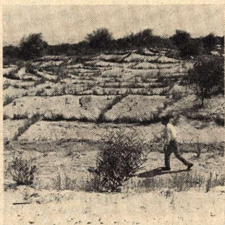
2. ábra. „Szárz-füves”-homokkötés a Tripoli-i nemzetközi műút mentén
