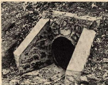
2. ábra. Az átérés szárnyfalas fejkiképzése
