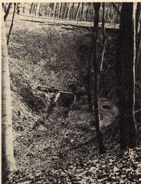
4. ábra. 118,5 cm névleges átmérőjű áteresztő mély vízmosásban
