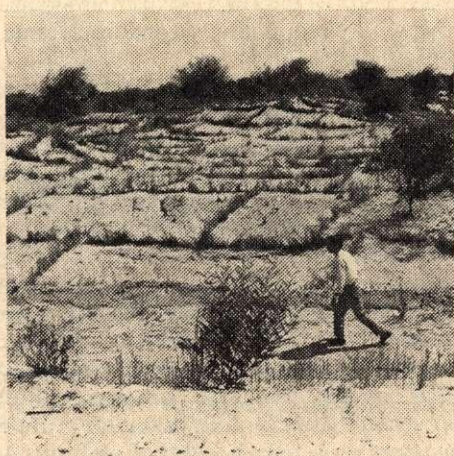
2. ábra. „Szárz-füves”-homokkötés a Tripoli-i nemzetközi műút mentén
