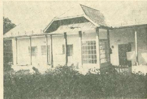
A volt Fényesi Erdőgondnokság épülete
