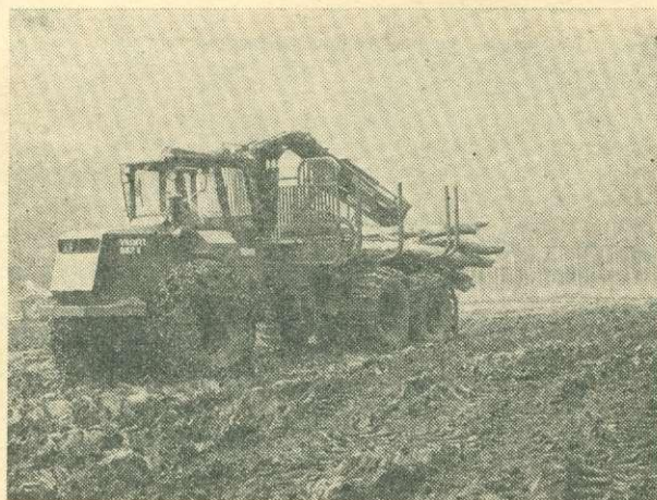
8. ábra A VALMET 882 K kihordó vontató
