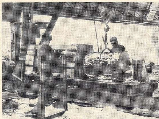
5. ábra: A nagyobb tönköket a daru helyezi a hasító-gépbe
