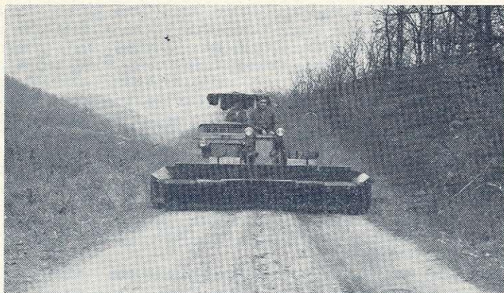
1. ábra. Jellegzetesen megsüllyedt burkolat az aszfalterítő gép előtt
