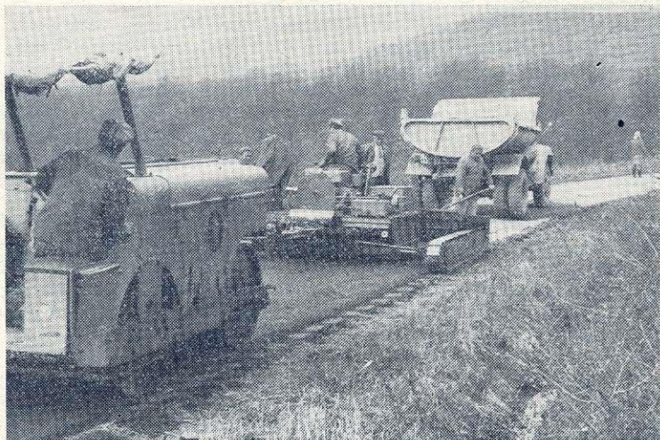
2. ábra. Aszfalterítő gépsor: billenőplatós ZIL, RAB-25C finisher, VVS-2 csehszlovák úthenger
