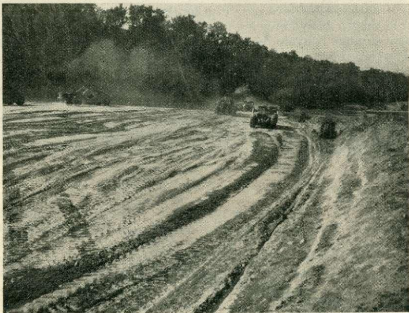
A termőtalajt elkülönítetten fejtő szkréperék
