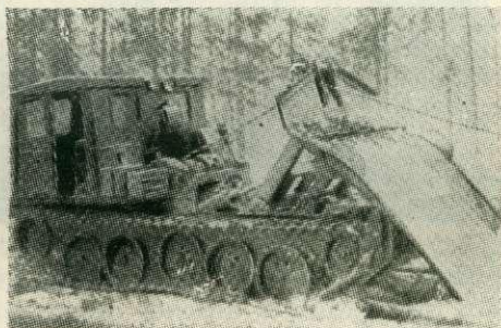
TDT. 54. új közelítő traktor rakodás előtt leeresztett rakodólemezzel és szálfaköteg vontatása közben
