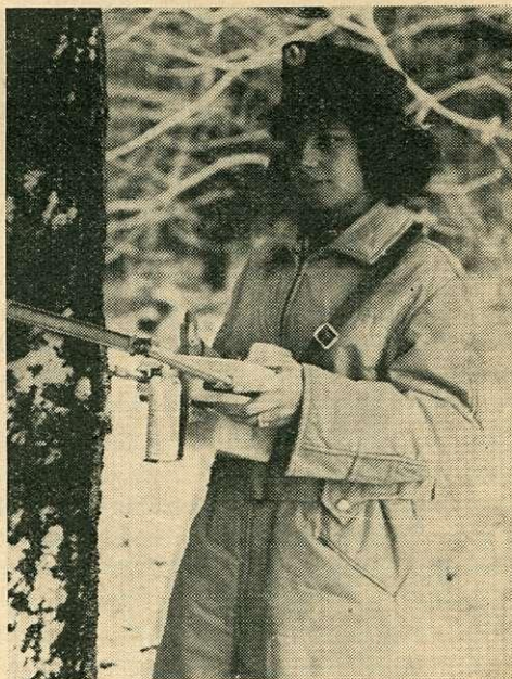
Álló fa mérése és jelölése a Kyrítz-i átlalóra szerelt festékszóróval
