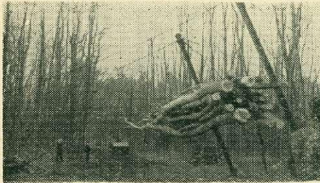
7. ábra. Árbocos csörlő egyszerre emel fel 6 to rakományt pótkocsi megrakása során
