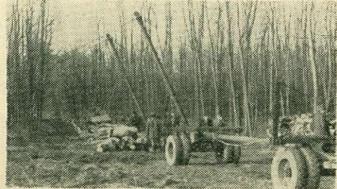
5. ábra. Árbocos csörlő (10 t teherbírási) rakodás közben
