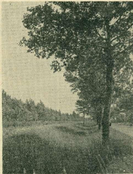
2. ábra. A padkára ültetett erdősáv mentén futó platán fasor, bár esztétikailag kevésbé, de szakaszpontból erősen kifogásolható (8-as műút Devecser környéki szakasza. Foto: Tompa)
