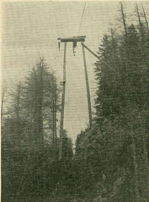
1. ábra. Egyszerű kihorgonyzott, illetve kidúcolt faállvány felső vonókötél vezetéssel
