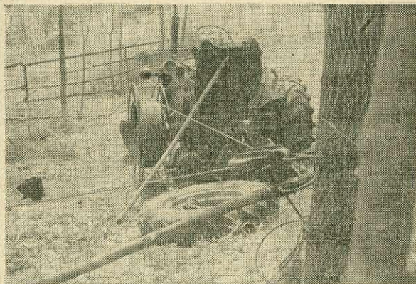
6. ábra: Traktor provizórikus felhasználása kötéldaru meghajtásához
