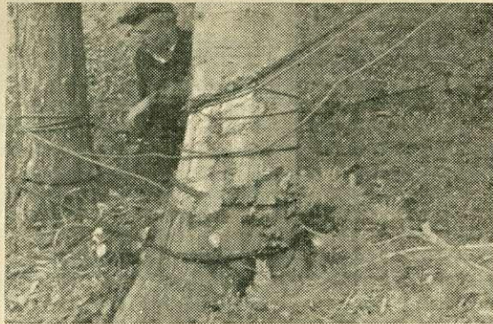
7. ábra: A kihorgonyzó fa súlyos sérülése
