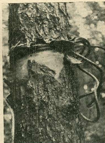
10. ábra: A felterhelő állomás kikötésének jellegzetes súlyos sérülései
