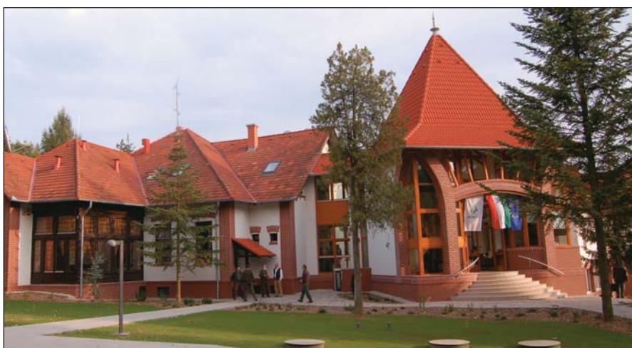
A felújított vadászház főbejárata
