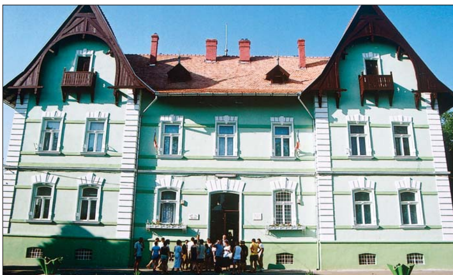
A temesvári iskola felújított főépülete
