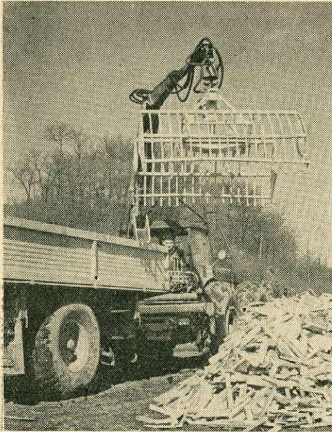
4. ábra. HIAB—173 típusú önrakodó daru, a Mecseki Áll. Erdőgazdaság fűrészhulladék markolójával
