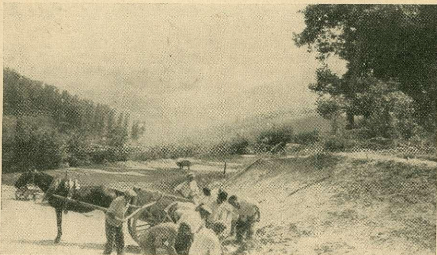
Folyik a feltárhálózat építése a Sátorhegyi Kemencepatak-völgyben
