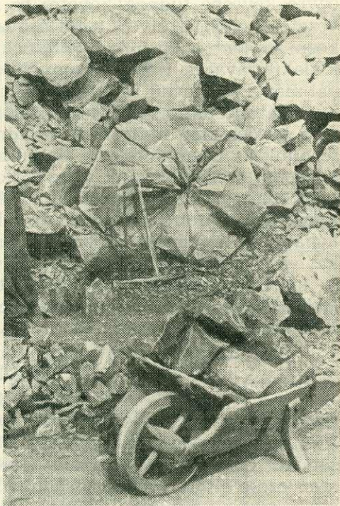
Nagyobb kőtömbök batározásra való elő-készítése, felfúrása (Fotó Zágoni)
