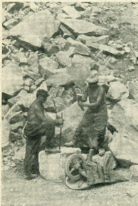
Batarózás alkalmával a kőtömb robban-tásutáni állapota. Fontos, hogy a kőtömb repedjen és ne szétrepüljön. (Foto Zágoni)
