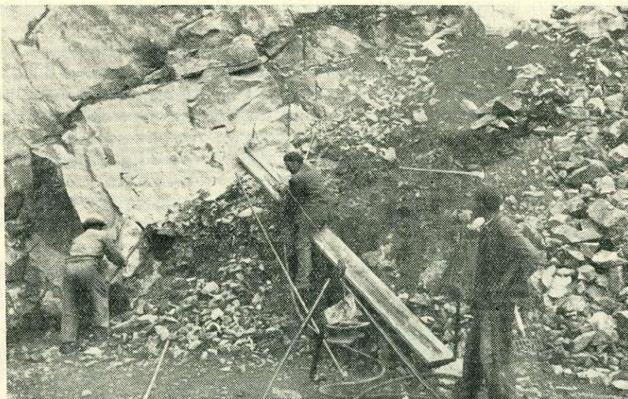
A vízszintes vagy kívánt dőlésszögű furatok készítésére szolgáló fúrópad, s annak ellensúlya állványon (Foto Zágoni)
