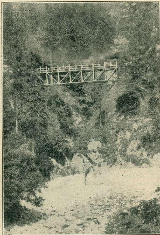
Az offensee-i erdei vasút vasszerkezetű hídja a Klamm-szakadék felett.
