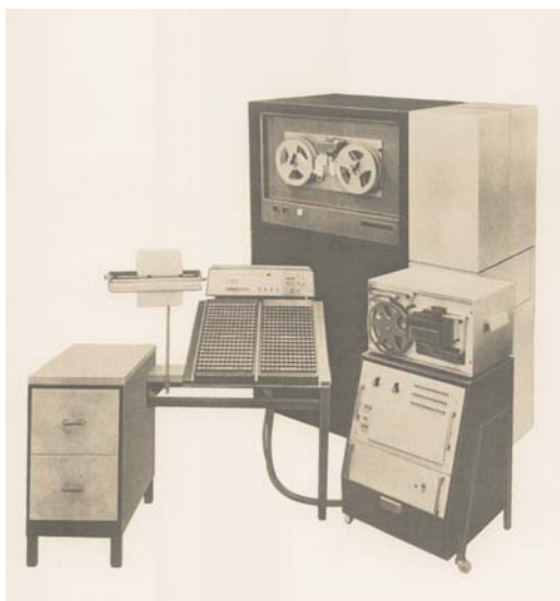
A korai Monophoto 600 fényszedő rendszerben még felismerhető a monókopogtató klaviatúrája, de a lyukszalag 8 csatornás, a számításokat pedig a szövegrögzítőbe beépített számítógép végzi. A levilágító különálló egység
