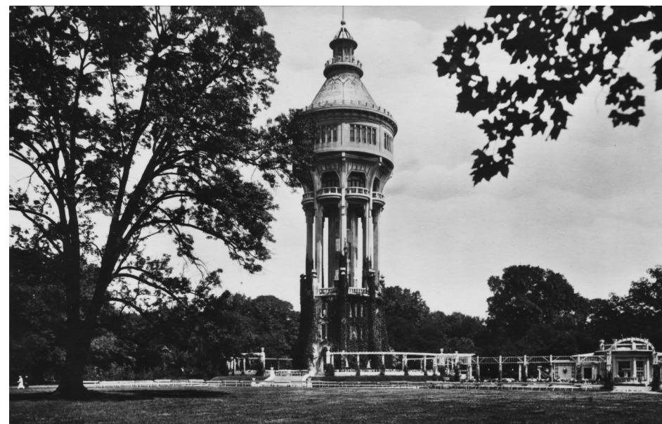
Dr. Zielinski Szilárd egyik legszebb alkotása Budapesten: a margitszigeti víztorony. (Képeslap Láncki András gyűjteményéből)
