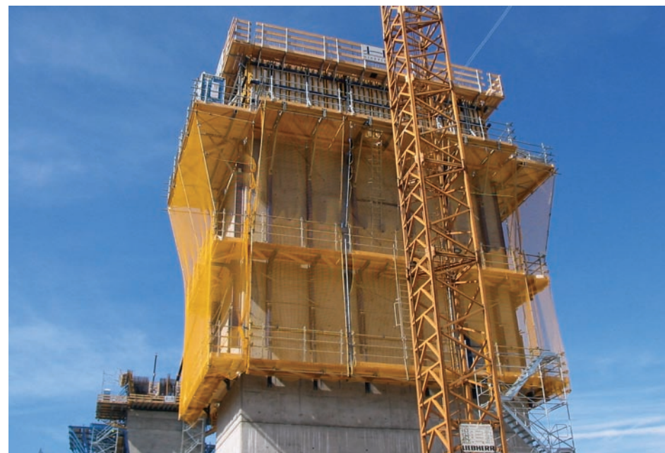
4. ábra • Pillér építése kúszó zsaluzattal
