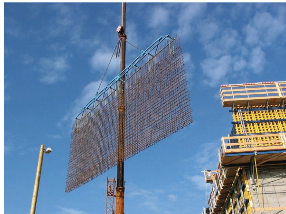
5. ábra • Előszerelt vasalás beemelése
