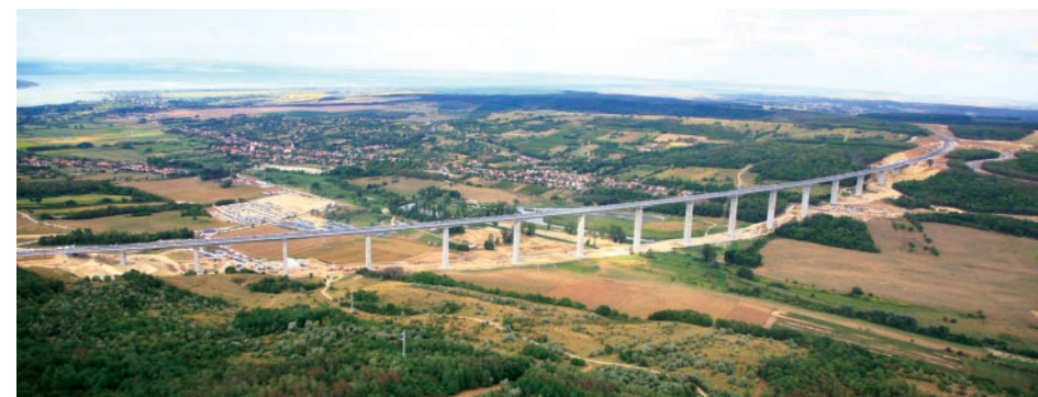
1. ábra • A megépült völgyhíd
