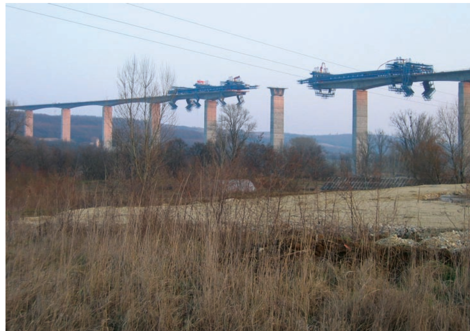
7. ábra • A két hídfőtől épített szerkezet találkozása
