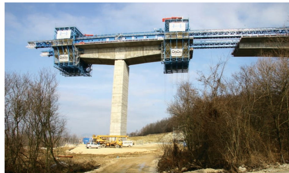
3. ábra • Egy szakasz építése szabadbetonozásos technológiával
