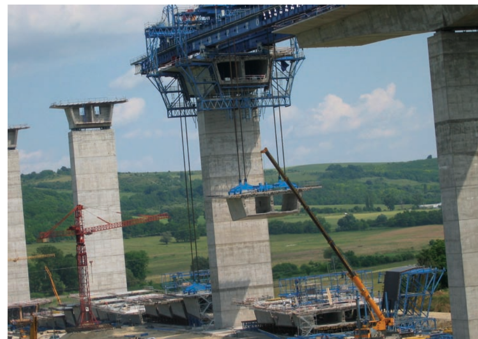
5. ábra • Az új technológia alkalmazása előregyártott elemekkel
