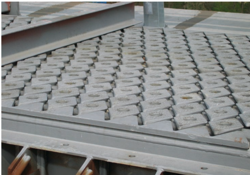
6. ábra • A modern dilatációs szerkezet
