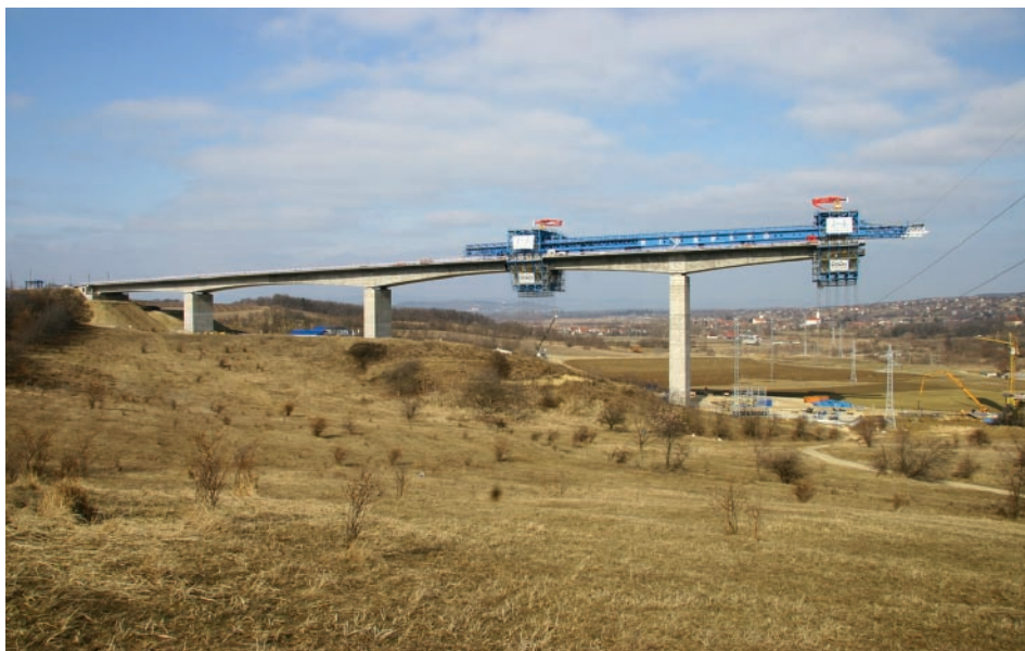
4. ábra • Az új hídág összekötése a korábban elkészült hídrésszel
