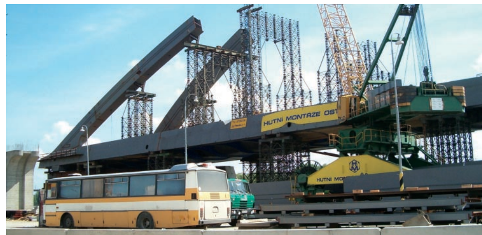
8. ábra • A mederhíd szerelés közben
