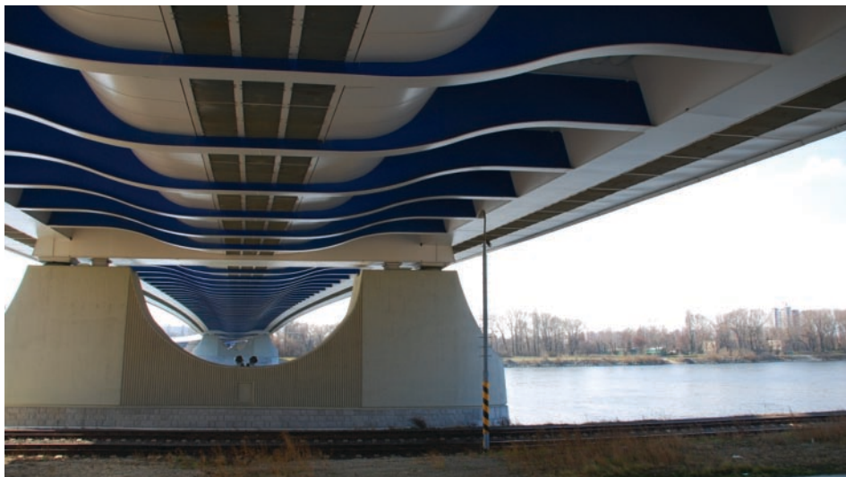
5. ábra • A híd alulnézetből
