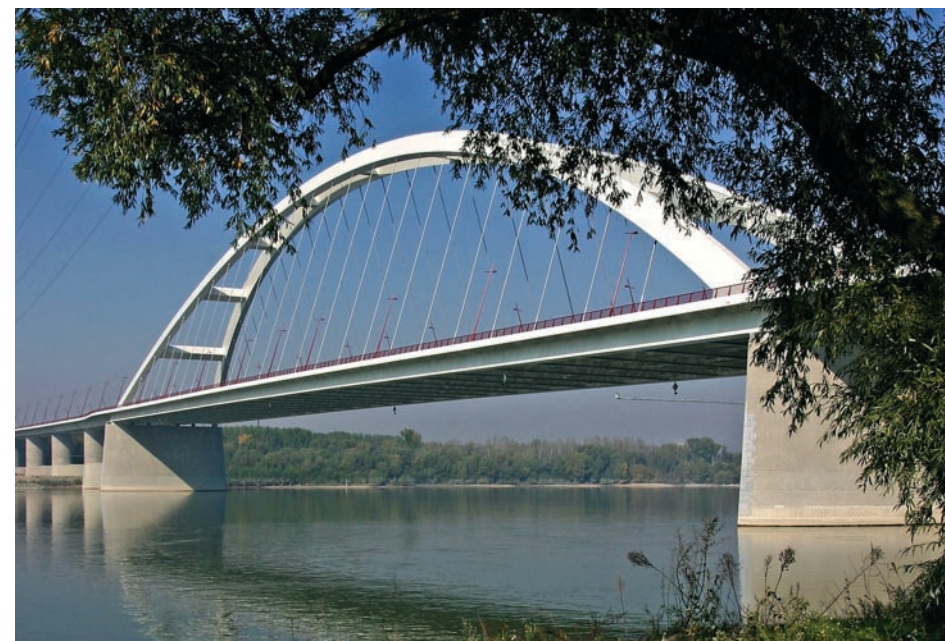
22. ábra • Az elkészült híd
