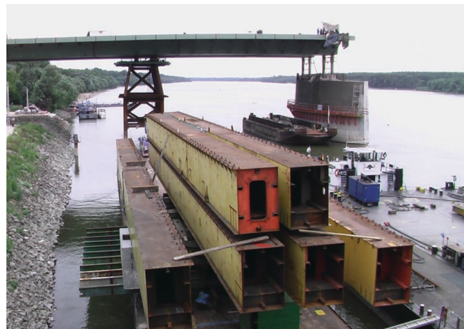
19. ábra • A bárkák próbaterhelése
