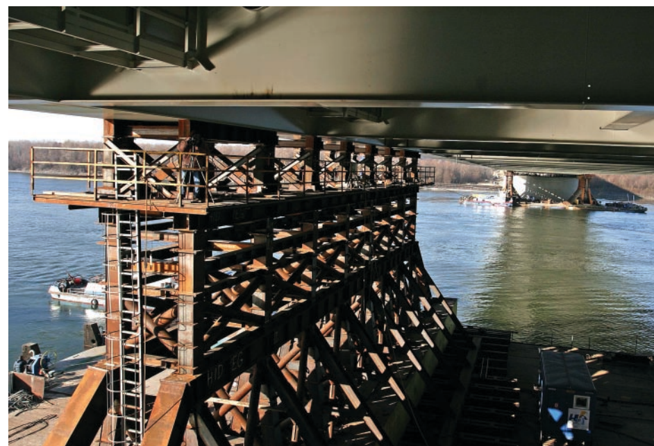
17. ábra • A bárkákra épített állvány, a híd egyik sarka közelében, 16 ponton támasztotta meg a merevítő gerendát
