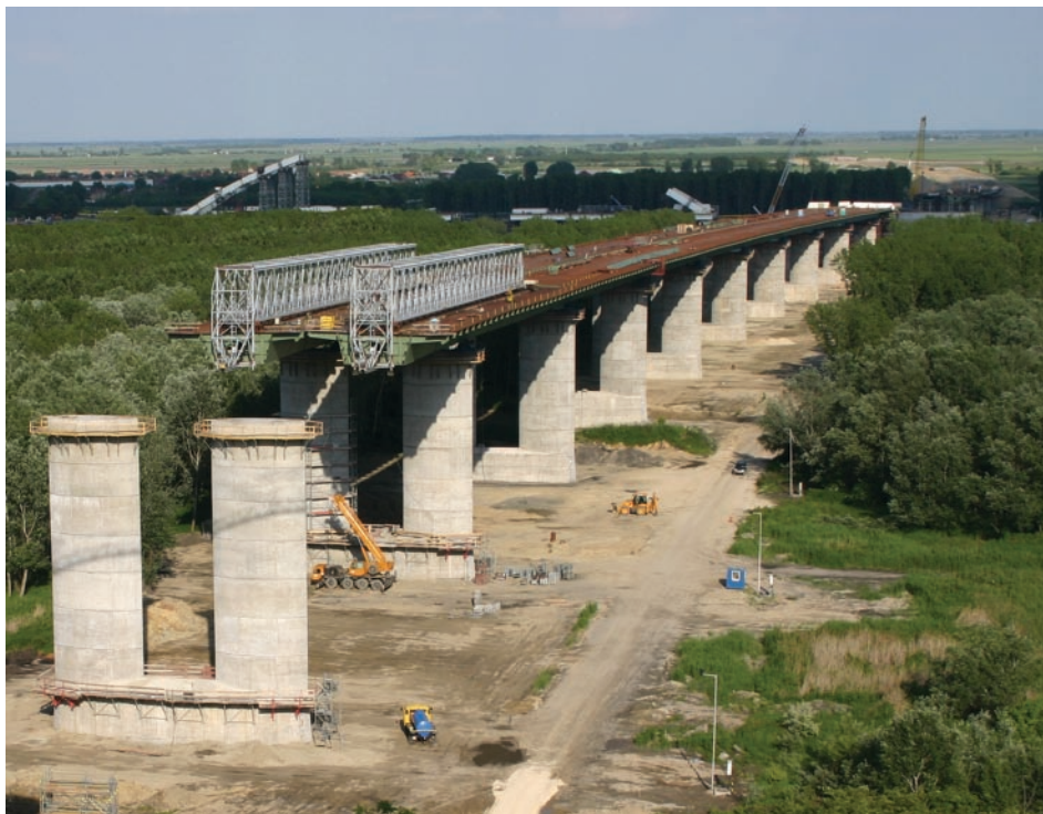
20. ábra • A jobb parti ártéri hidak felszerkezetét rácsszerkezetű gerenda, ún. vendéghíd segítségével, szakaszosan előretolva építették.
