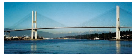
3. ábra • Ferdekábeles híd Alex Fraser híd a Fraser-folyó fölött, British Columbia, Kanada
