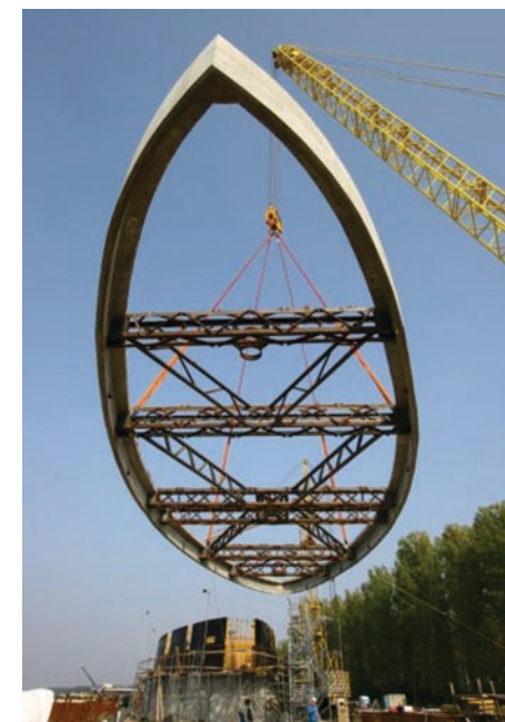
21. ábra • A mederpillérek építésénél használt egyik kéregelem áthelyezése a gyártótéren
