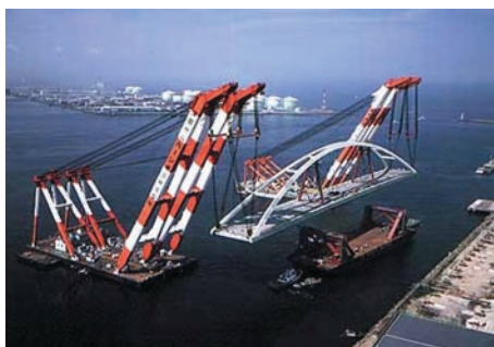
13. ábra • A Shinhamadera híd elszállítása a szerelótérrel (Oszakai-öböl, Japán)
