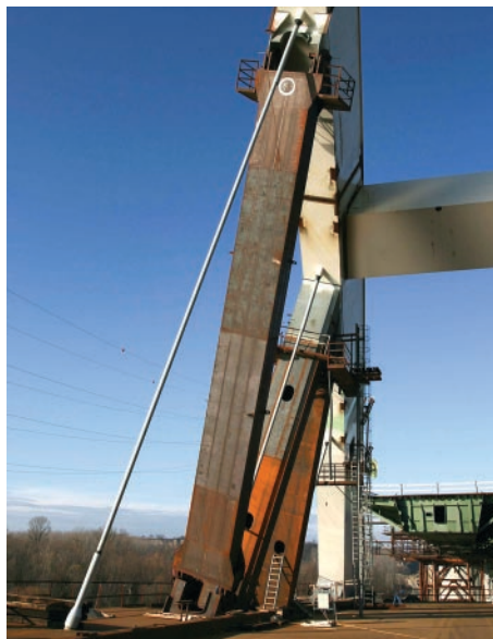
15. ábra • Ideiglenes merevítő rudak a bárkák alátámasztott mederhídiban. Hozzánk legközelebb a csuklós bekötésű rúd
