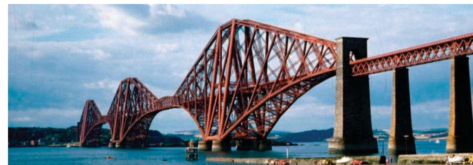
1. ábra • A Firth of Forth vasúti híd (Baker, Anglia, 1890, támaszköz: L=521 m. Fényképezte Kollár Lajos)
