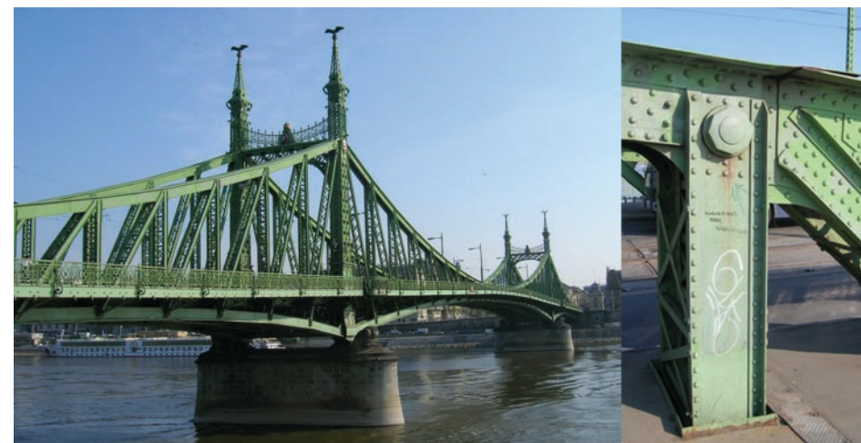
2. ábra • Szabadság híd (Feketeházy János, Budapest, 1896, támaszköz: L=171 m) A jobb oldali képen látható a befüggesztett rész megtámasztása.
