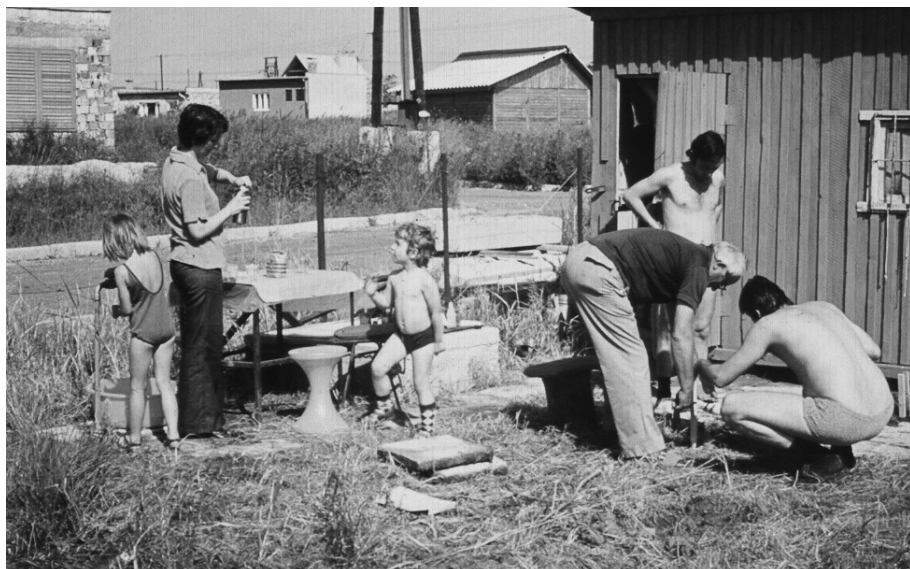
3. kép. Alapkitűzés a sufni tővében, Csordás úti nyaralótelep, Balatonakali (a Puskás család tulajdonában)
