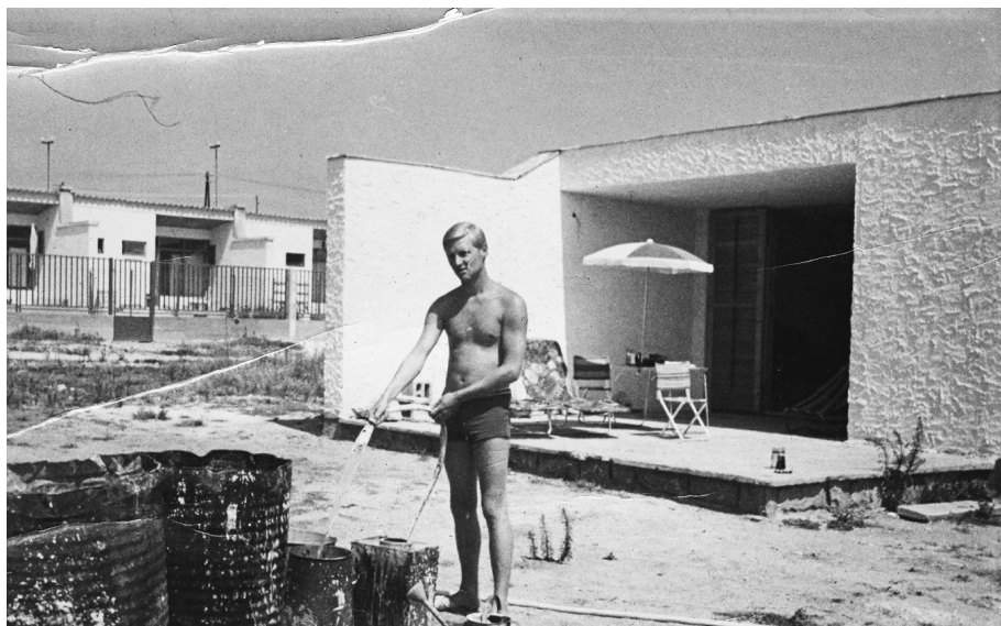
5. kép. Épül a „Gyékény” (a Dévényi család tulajdonában)
