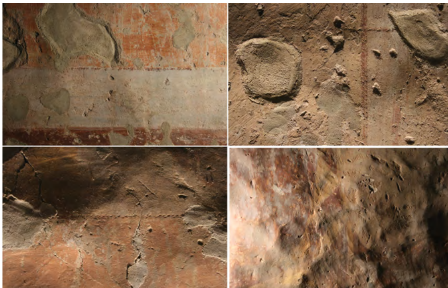
22. kép. Nyugati oldal, karzat alatti rész: az enyhén dőlt hosszanti vakolathatár, az eszköznyomok, a képmezők vízszintes és függőleges vonalainak kijelölésére használt, vörös festékbe mártott kicsapózsineg lenyomata. Sűrűfényes felvételek
