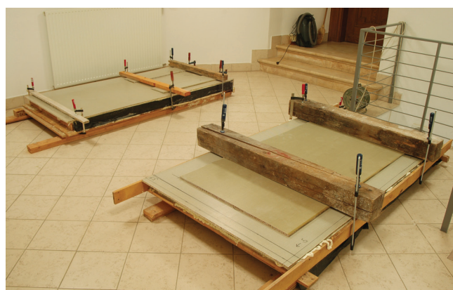
13. kép. Alumínium méhsejt lemezek felragasztása a freskók hátuljára egykomponensű poliuretánhab segítségével.
