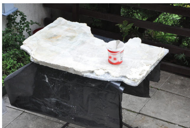
23. kép. A freskó további stabilizálása poliuretánhabbal és perlités vakolattal.
