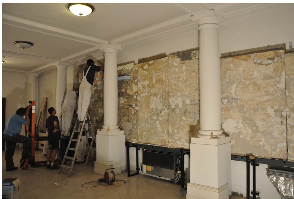
14. kép. A gödöllői kastély mellett a föld alatt talált új hordozókra erősített falfestmény beépítése a kiállításba.
