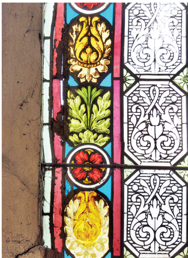
10. kép. Falstráfos rögzítés miatt sérült ablak, Szeged, Minorita templom, Palka József, 1906.
