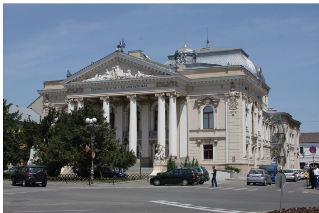
1. kép. A felújított színházépület.
