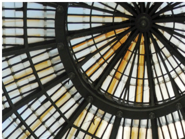
9. kép. Vasoxidtól szennyezett üvegpúpola Nápoly belvárosának elegáns üvegpaszszájában.
