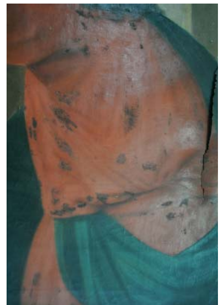
5. kép. A festett felület mechanikai sérülése és ráfestések nyomai.
