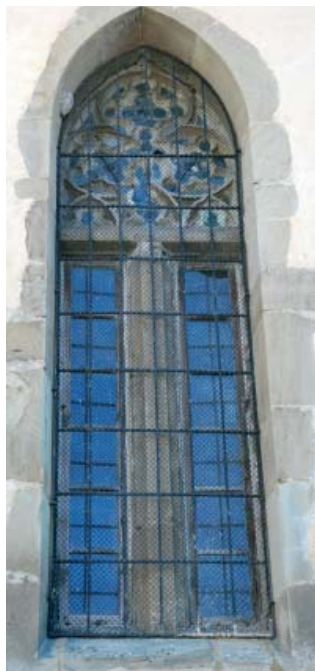
18. kép. Erdély középkori templomainak mérműves ablakait is fémsodronyok védik a külső oldalról. Szászivánfalva, evangélikus templom.
