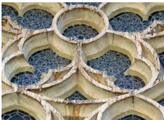
24. kép. Védelem nélkül a madarak gyorsan igénybe veszik és tönkreteszik a frissen felújított kőkereteket és az üvegeket. Fotó: a szerző.
