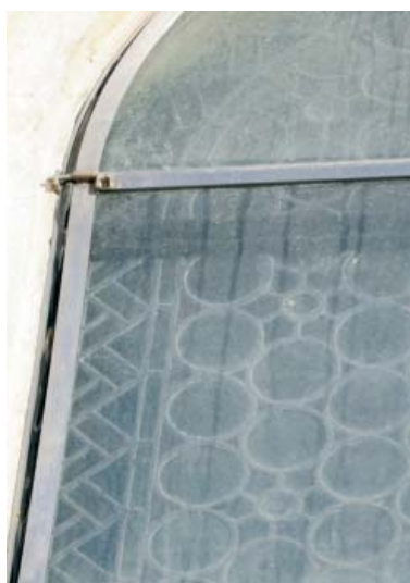
7 kép. A fémsodrony nem véd meg a löfegyverektől. Kalocsa, székes-egyház.
