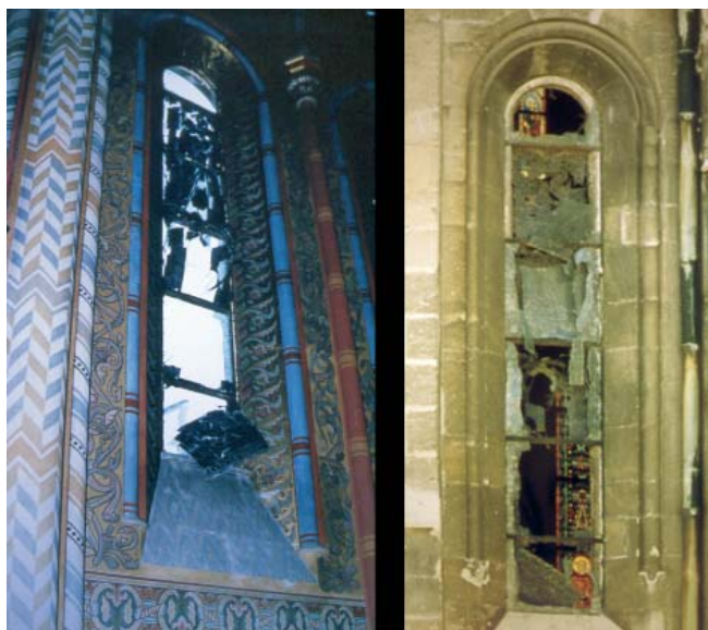
11. kép. A drótbetétes védőüveg a robbantás következtében kilökte a mögötte lévő üvegfestményt. Budavári Mátyás-templom.
