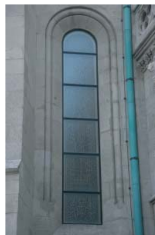
16. kép. Rusztikus felületű üveget alkalmaztak védőüveggént a budavári Mátyás-templomban. Szent József ablak.
