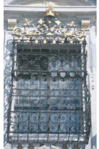
31. kép. A palota míves barokk kovácsoltvas díszrácsai aranyozott koronás díszítésekkel. A négyzetes alosztású ablakelemek eltűnnek a díszítések mögött. Ausztria, Maria Taferl.
