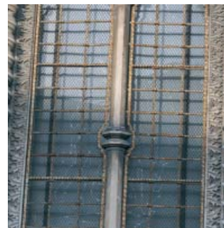
27. kép. A rácsokat és sodronyokat régebben együtt használták. Ezek ma is remekül funkcionálnak.
