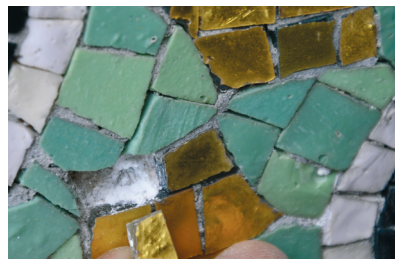
17. kép. A kikristályosodott sók a mozaik romlását idézik elő. Megszűnik a mozaikszemek és a beagyazó vakolat közötti kötődés.
