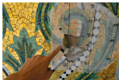
18. kép. A sók okozta károsodás nyomán kötést veszített mozaikrészlet levédése után, visszarögzítése előtt.
