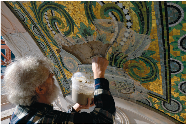
24. kép. A mozaik rekonstrukció kisebb részletekre felszabva történő beépítése. A képen Bóna István.
