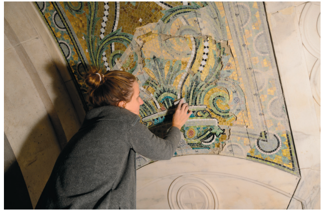
26. kép. A rekonstruált és az eredeti részletek „összevarrása”. Bóna István felvétele.
