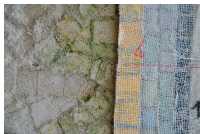
19. kép. A leválasztott mozaikrészlet alatt a nedves környezetben a moszatok is megtelepedtek.
