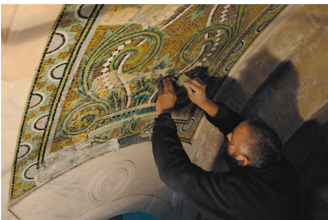
25. kép. A rekonstrukció beépítése után az illesztések összedolgozása direkt rakással. A képen Balázs Miklós Ernő.
