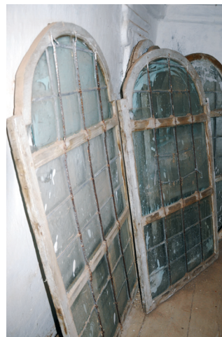
8-9. kép. Fakeretes ablak a székydályai templomhajóban, és a karzaton tárolt négy ólomzással készült fakeretes ablak.
