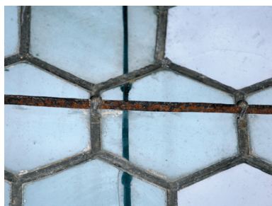
18. kép. Külső és belső oldali merevítések.
