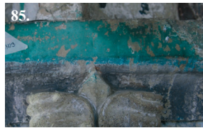
85. kép. Mintavételi hely az észak-keleti falon a boltozat indításánál. Zöld minta a kőről.
