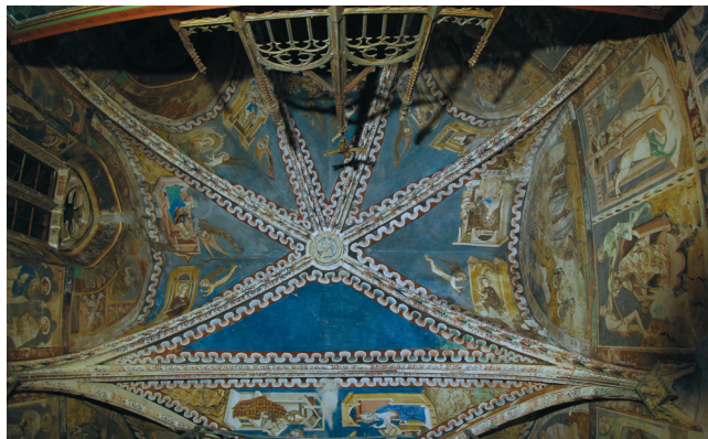
1. kép. Az apszis keleti boltszakasza normál fényben.
