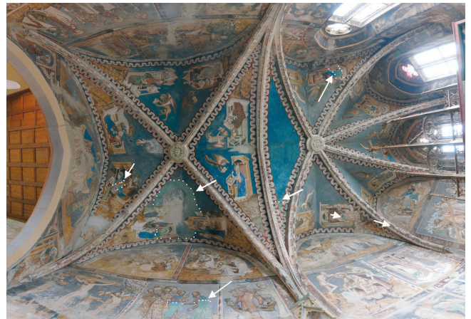
78. kép. Áttekintő kép, nyilak jelölik az elzöldült azurit felületeket.
