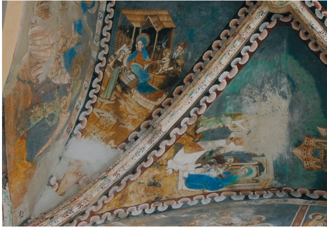
80. kép. Az eredetileg kék háttérszín zölddé változott a nagy kimosódott folt mentén.
