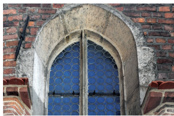
3. kép. Az üvegtáblák beépítése a kőkeretbe, laposvasak segítségével.
