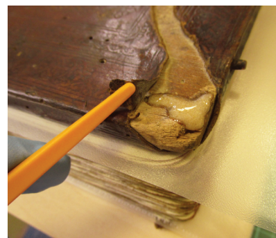
17. kép. A fatábla hiányainak kiegészítése.
