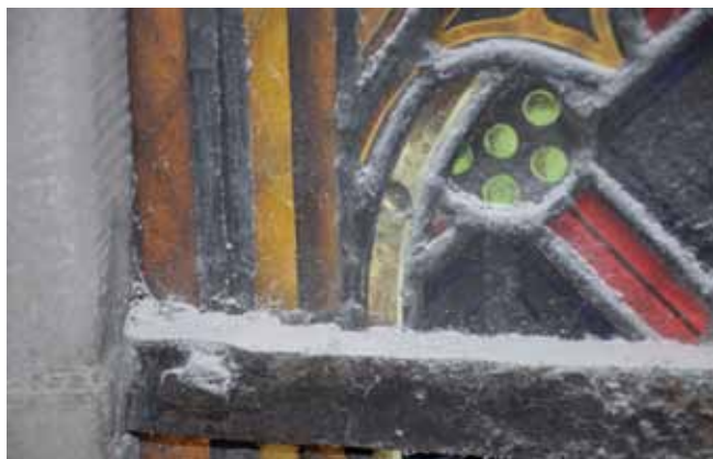
4. kép. Kőkávéba habarcs nélkül, egymáshoz fogatott laposvasakkal beépített ablakelemek. Kassa, Szent Erzsébet dóm.
