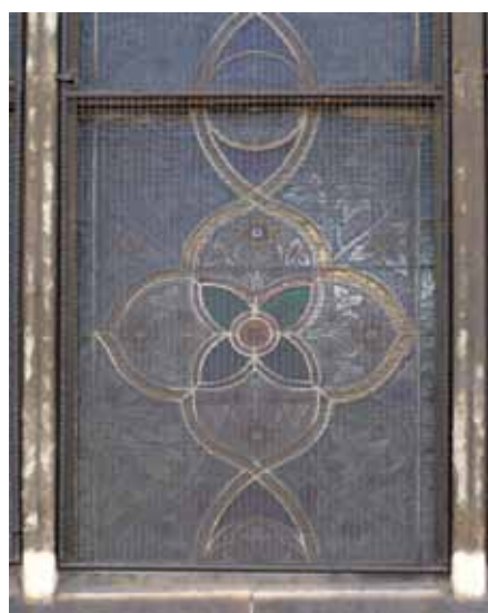
2. kép. Az ornamentális ablakokra belülről tettek egy-egy pár merevítő vasat.
