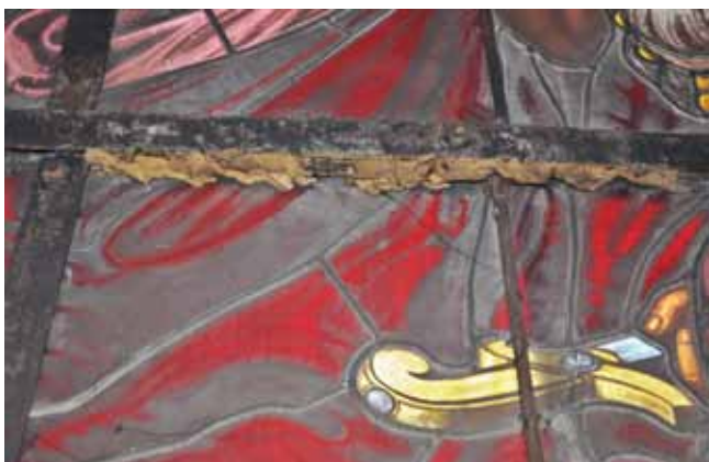
29. kép. A kettő kicsúszott a laposvasak közül. Szeged, minorita templom.
