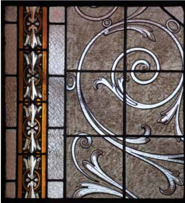
21. kép. Négyzethálóban egymáshoz kötött nagyméretű üvegelemek. Kalocsa, érseki főszékesegyház karzati ablak.
