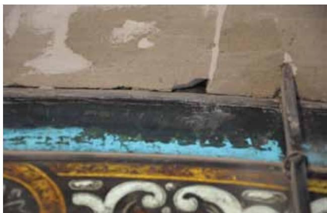
15. kép. Falstráfos beépítés. Kalocsa, az érseki főszékesegyház koronázó parkány feletti ablaka.
