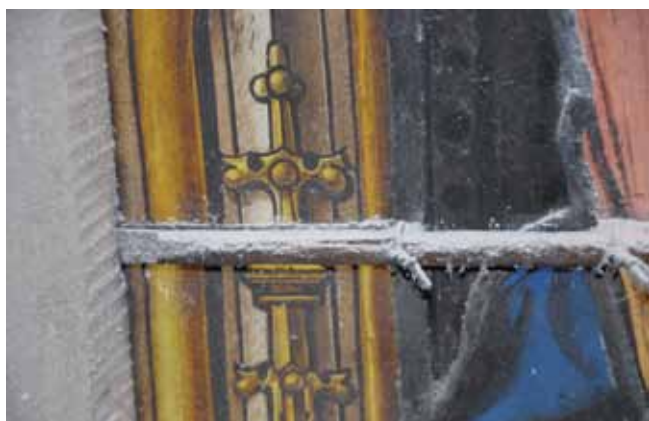
5. kép. Belülről a felületre erősített mervítóvasak, Kassa, Szent Erzsébet dóm.
