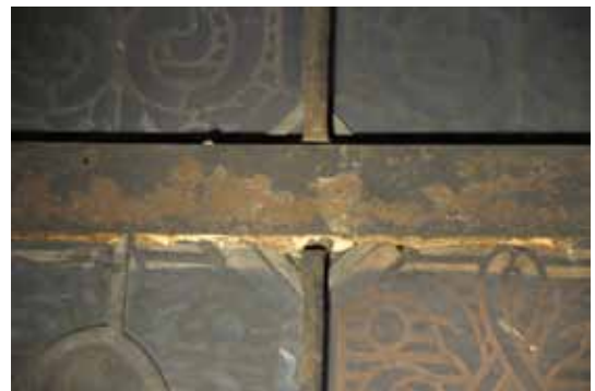
25. kép. A függőlegesen futó merevítővasak szélei be vannak kötve a vízszintes laposvasakba. Szeged, minorita templom.
