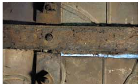
27. kép. A függőleges és vízszintes irányból egymáshoz csatlakoztatott laposvasak nem képesek stabilan tartani a mezőket, így azok kiszakadhatnak a keretből.
