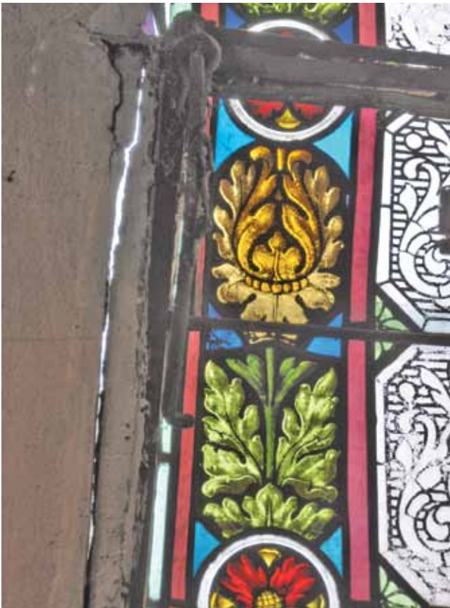
18. kép. A falstráf a vakolattal együtt kiszakadt az üveglablak falazatából. Szeged, minorita templom, déli falazat.
