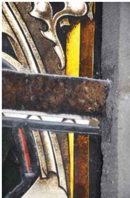
6. kép. Az alsó mező felső szélé kicsúsztott a laposvas rögzítésből, Kassa, Szent Erzsébet dóm.
