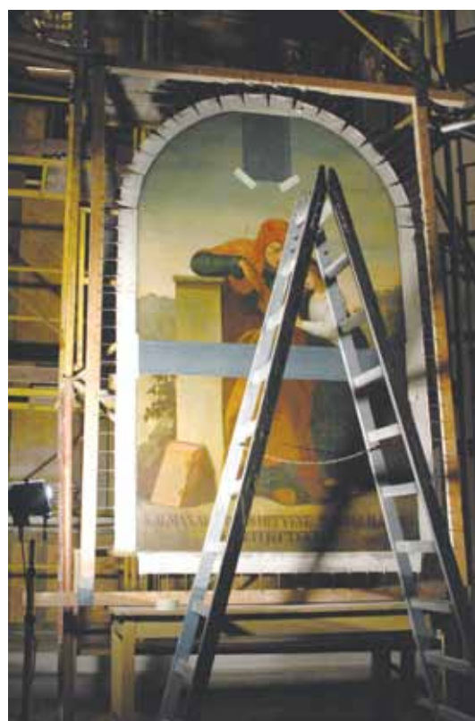
27. kép. A nagyobb benyomódások simítása mágnesek segítségével. A képpoldalon bádoglemezek vannak a kérdéses részekben.
