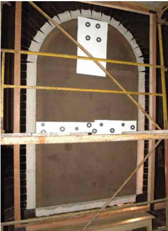
28. kép. A hullámok kiprélésése a hátoldal felől mágnesekkel és habkarton lapokkal.
