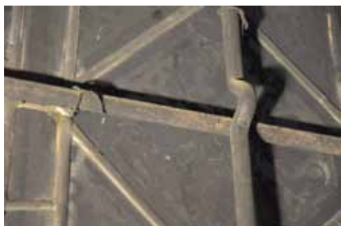
32. kép. Elcsúszott merevítővasak. Szeged, minorita templom.
