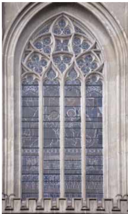
4. kép. Kőkávéba habarcs nélkül, egymáshoz fogatott laposvasakkal beépített ablakelemek. Kassa, Szent Erzsébet dóm.
