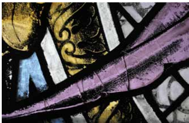
31. kép. Sorozatos üvegtörések egy vetemedett felületen. Szeged, minorita templom.
