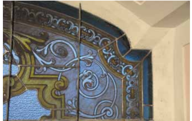
12. kép. Ornamentális ablak ún. falstráfos beépítési módja a kalocsai főszékesegyházból – restaurálás utáni állapot.
