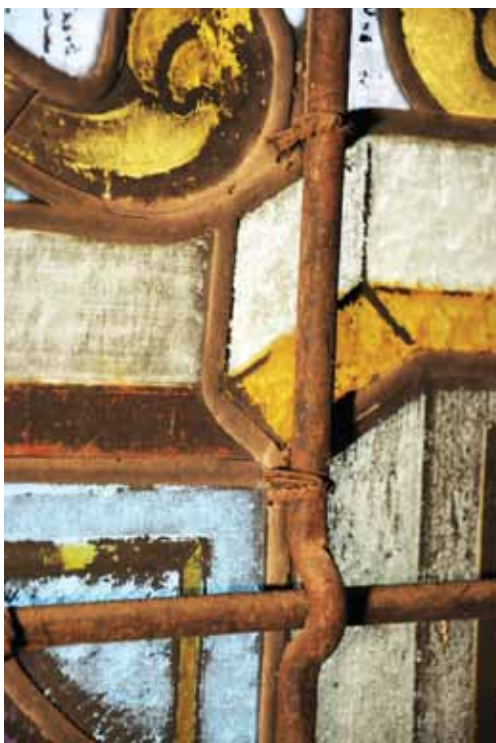
30. kép. Ívben meghajlított függőleges merevítővasak, melyek a vízszintes vasakat is tartják. Szeged, minorita templom.
