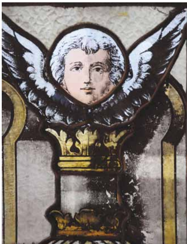
33. kép. Erős vízkölerakódás következtében kialakult szennyeződés. Szeged, minorita templom szentélyablak.
