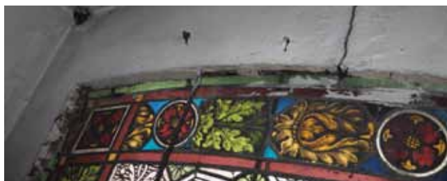
17. kép. Átrepedt falazat. Szeged, minorita templom déli oldal.
