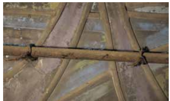
26. kép. Acéldrótokkal felfogatott függőleges merevítővasak. Szeged, minorita templom.
