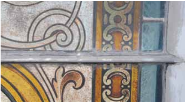
19. kép. Tömítés nélküli T profil tartószerkezet. Az üvegmezőket a fémbe fűrt fastiftek tartják a kittágy alatt. Kalocsa, érseki főszékesegyház.
