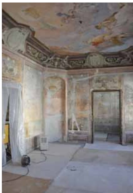
2. kép. Az ebédlő a megtisztított, konzervált és kitömített oldalfalakkal és a restaurált mennyezettel.
