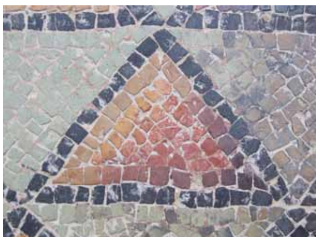
5. kép. A nagy hőhatás okozta színváltozás jól látható az apszis mozaik részletén.
