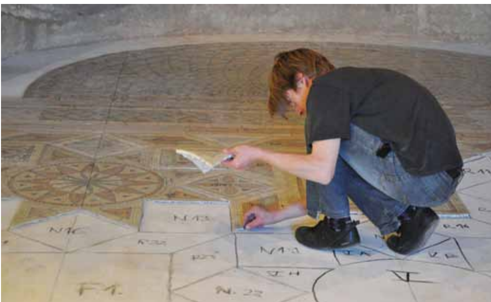
19. kép. Az egyes elemek helyének felrajzolása, és jelölése a grafikus térkép alapján.
