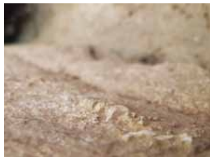
7. kép. A fehér beágyazóhabarcs (supranucleus) maradványa.
