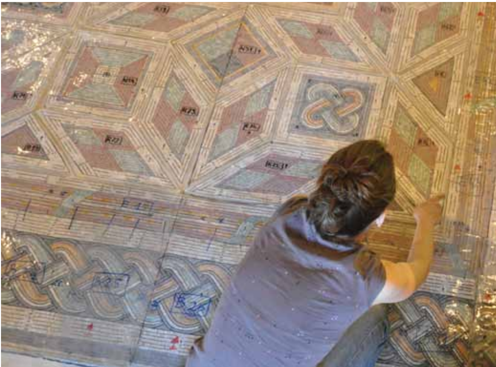
18. kép. A motívumok kirakása szárazon a balácai tablinum új aljzatára.
