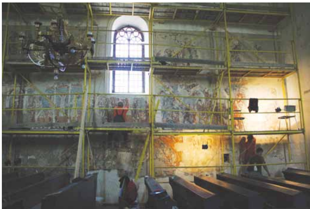
2. kép. Bögöz, az északi hajófal restaurálás közben.
