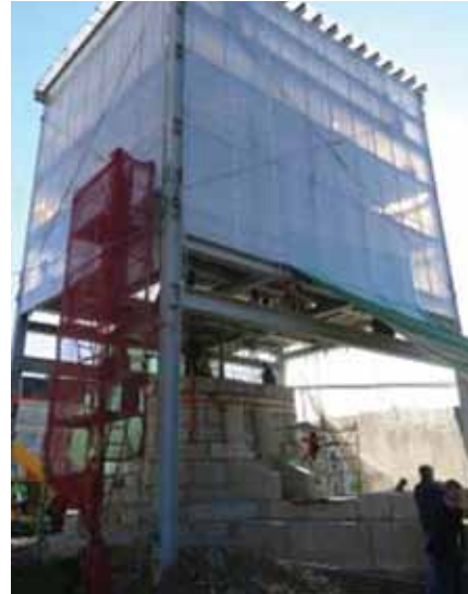
11. kép. A Mátyás szobor talapzatának újjáépítése a téliesített restaurátor-műhely alatt.
