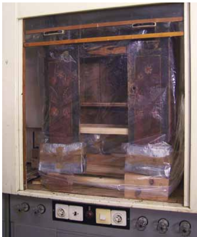
9. kép. Az alsó elem korhadt részének szilárdítása.
