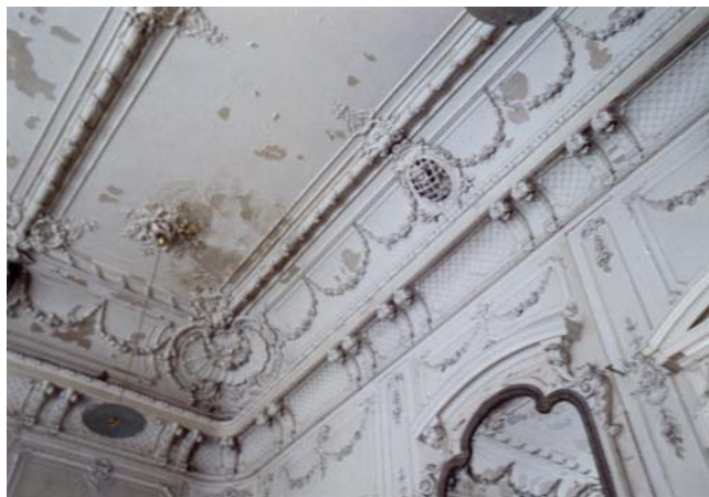
2. kép. Gipsz és masé stukkók vegyes alkalmazásban. (Festetics palota, Budapest, 19. sz., szerző felvétele)
