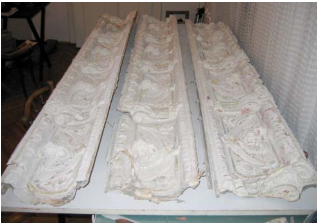
19. kép. Két méter hosszú lécvázás masé tagok. (Budapest, Horánszky utca, 1890-es évek, a szerző felvétele)
