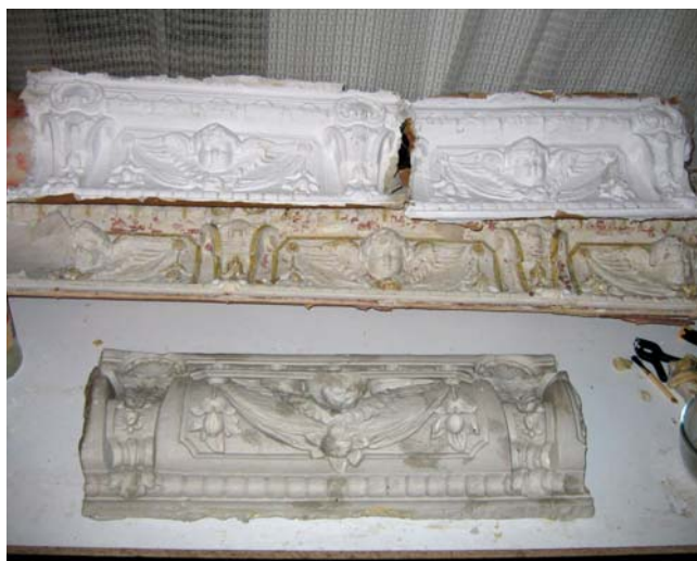
21. kép. Az egy egységről levett gipsz negatív, és az abban készített 2 db pótlás masé. (szerző felvétele)
