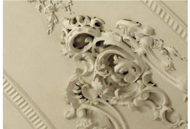
26. kép. Restaurált masé stukkó. (Királyi kastély, Gödöllő, 19. sz., a szerző felvétele)
