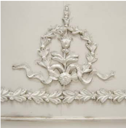
25. kép. Körülgipszelt kész masé motívumok. (Orczy kastély, Gyöngyös, 19. sz. a szerző felvétele)
