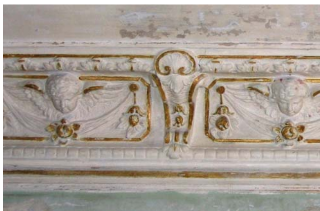
8. kép. Falon tisztított masé stukkó. (Budapest, Horánszky utca, 1890-es évek, Durkó Ádám felvétele)
