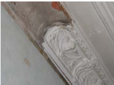
20. kép. Lécvázással merevített masé. (szerző felvétele)
