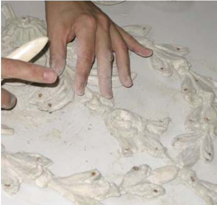
24. kép. Mechanikus tisztítás életlen csontkéssel. (szerző felvétele)
