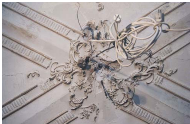
15. kép. Ember okozta sérülés csillár rozettáján. (szerző felvétele)
